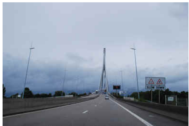
Pont de Normandie
